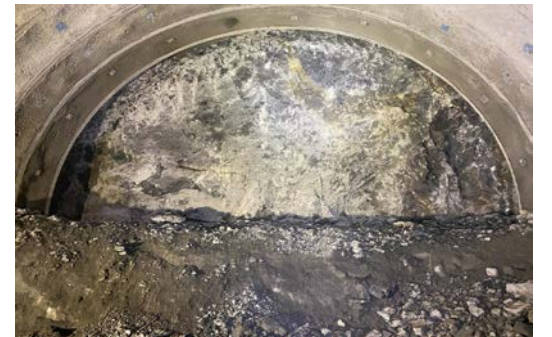
26.羊蹄トンネル(有島)他 シールドマシン組立状況
