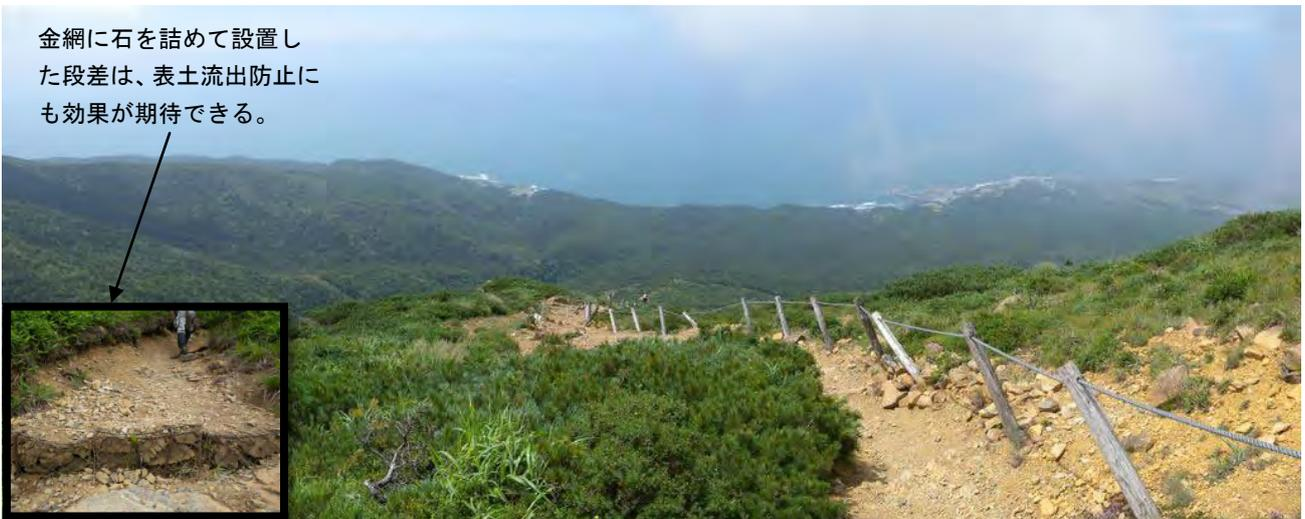
登山道外への踏み込みを防ぐために、アポイ岳ファンクラブではロープによるコースの明示とともに、オンコースを歩きやすくするために金網に石を詰めた段差を設置している。
