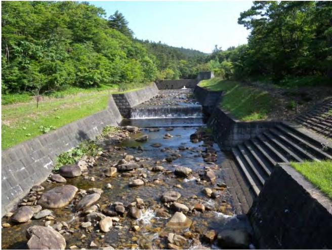
ポンサヌシベツ川の河川改修工事によるコンクリート護岸 昭和 58 年に建設省により実施された。
