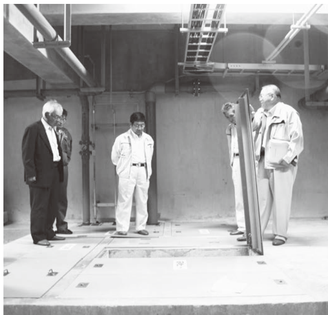
終末処理施設改修状況について
