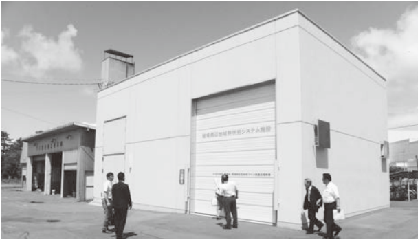
熱供給システム施設
