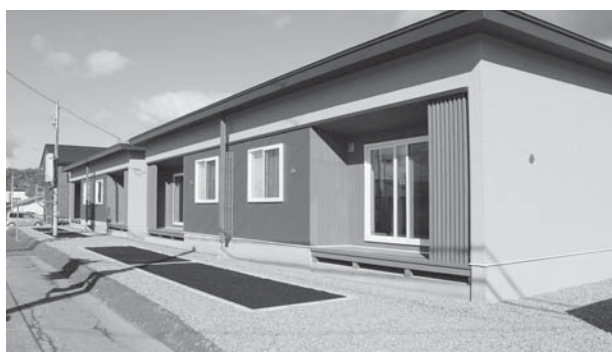
平成24年10月竣工 鶉町公営住宅
