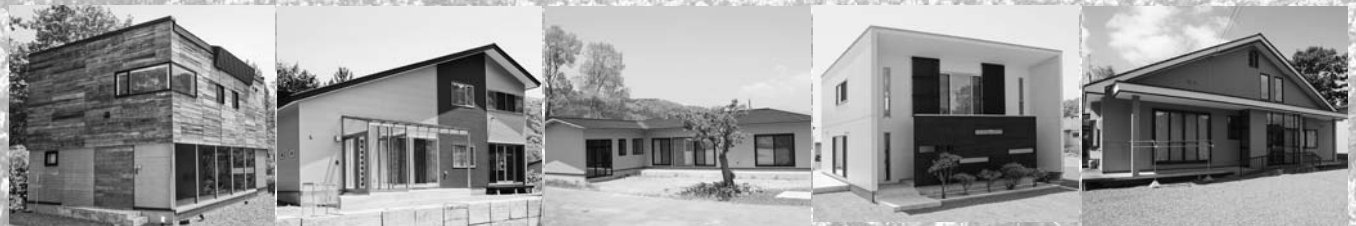
▲それぞれ雰囲気が違うちよつと暮らし住宅(左から本町にあるA棟とB棟、上里にあるC棟とD棟、E棟)
