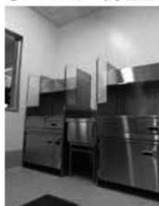
アレルギー調理専用室。換気・空調は他室と独立
