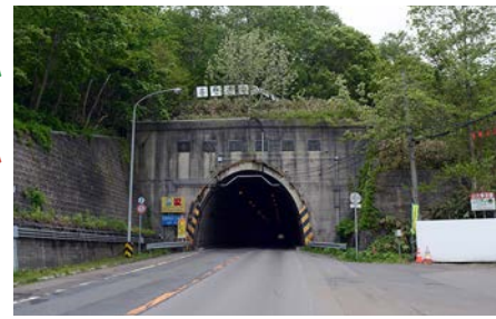
▲昭和38年着工の現中山トンネル。古いトンネルはこの右上の方にあります。右側では、新中山トンネルの工事が進行しています。
