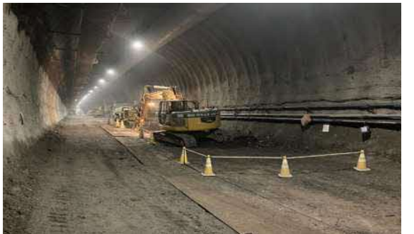
23.内浦トンネル(幌内)他 坑内状況
