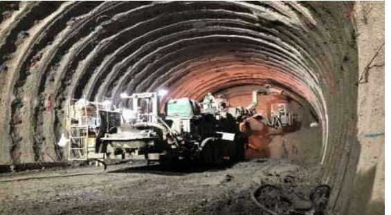
23.内浦トンネル(幌内)他 坑内状況
