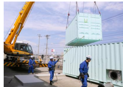
図 6.11 技術紹介（コンテナ型バイオマスプラント）
