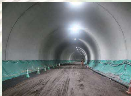
▲新中山トンネルの内部
