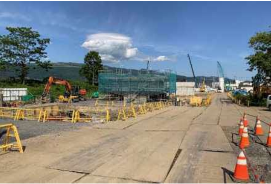
橋脚工事状況
