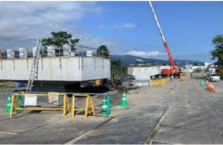
橋脚工事状況
