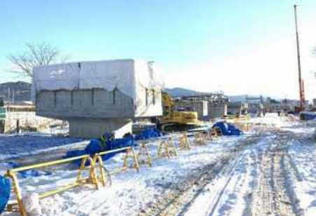
橋脚工事状況
