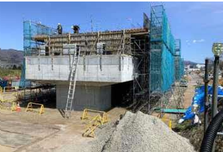
高架橋工事状況
