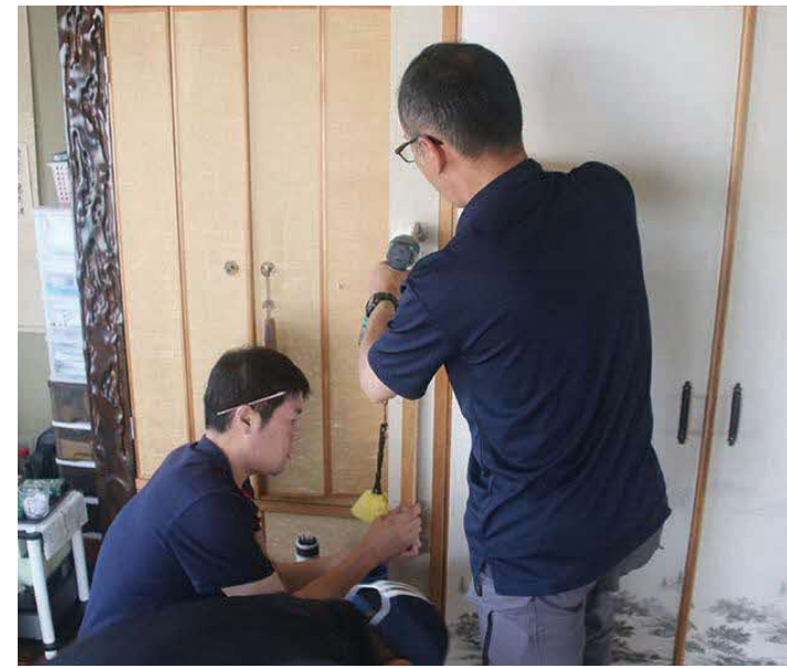
▲手際よく、スピーディーに作業していただきました！
