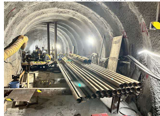
長尺先進ボーリング実施状況(南鶉工区)
