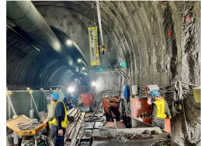
長尺先進ボーリング実施状況(南鶉工区)
