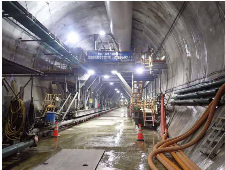
羊蹄トンネル(有島) 坑内状況
