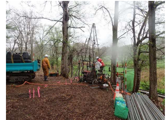
ボーリング調査状況
