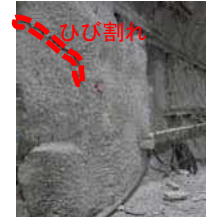
吹付けコンクリートのひび割れ
