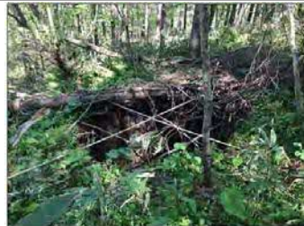
地表面陥没状況
