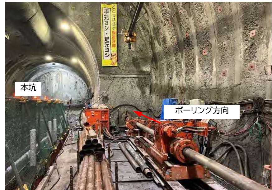
台場山工区ボーリング削孔状況
