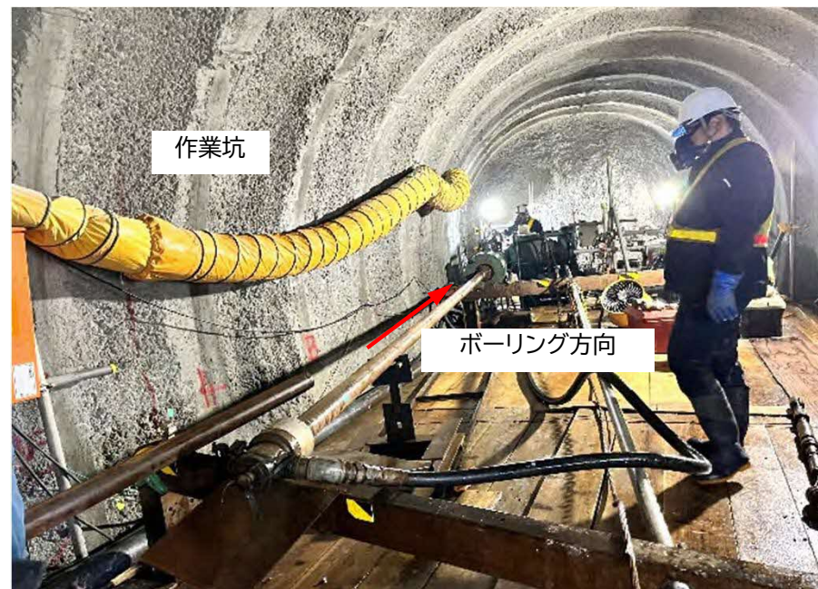
南鶉工区ボーリング削孔状況
