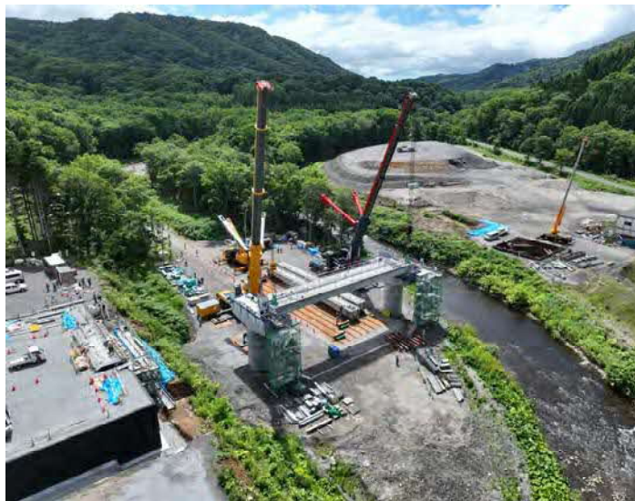
PCU形桁 架設状況
