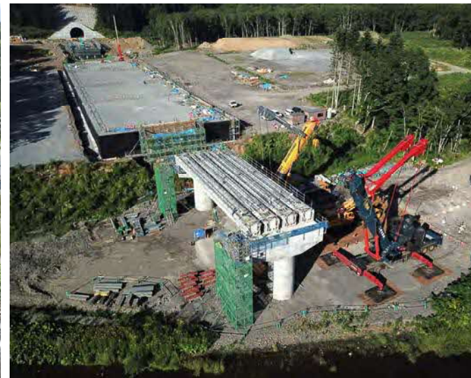
PCU形桁 架設状況
