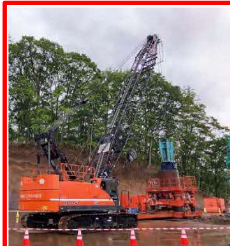
岩塊撤去状況
