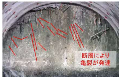
【特徴1】断層運動に伴う弱部の形成
