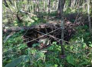
地表面陥没状況
