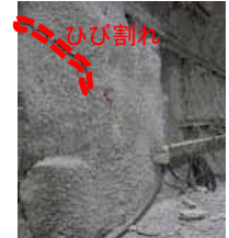
吹付けコンクリートのひび割れ
