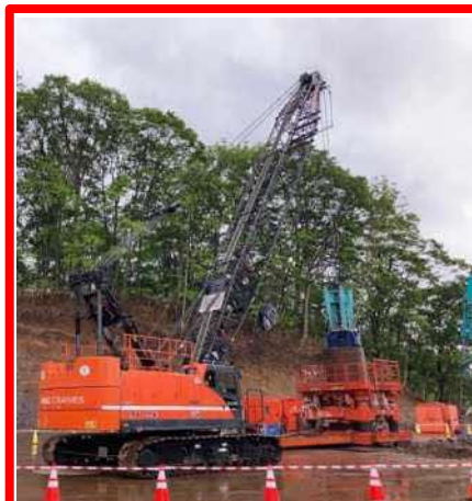
岩塊撤去状況
