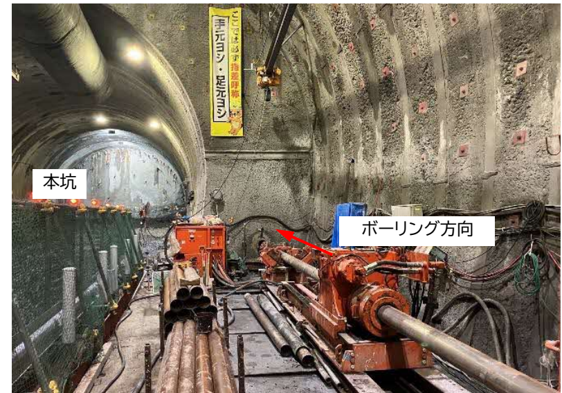
台場山工区ボーリング削孔状況
