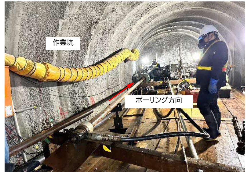
南鶉工区ボーリング削孔状況
