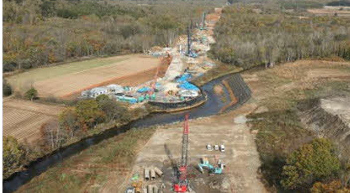
写真⑤ 琴平高架橋(倶知安町)
