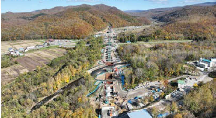
写真④ 明治高架橋(赤井川村)
