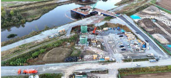
写真⑦ 岩尾別高架橋(倶知安町)
