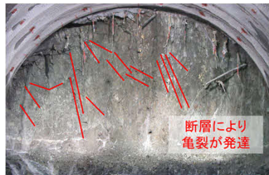
【特徴1】断層運動に伴う弱部の形成
