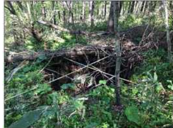
地表面陥没状況
