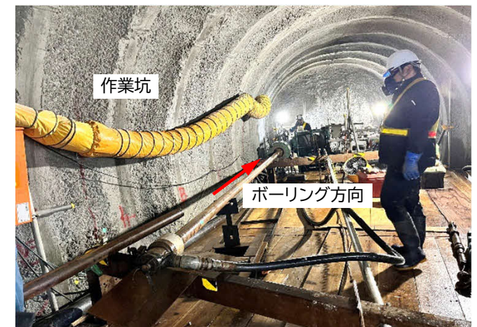
南鶉工区ボーリング削孔状況
