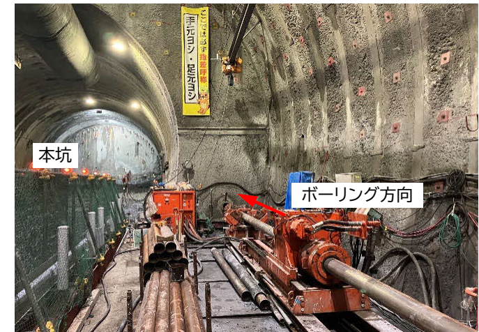
台場山工区ボーリング削孔状況
