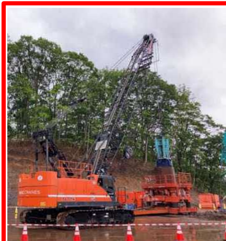
岩塊撤去状況
