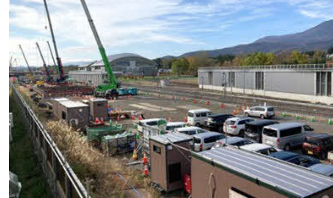
写真⑥ 倶知安駅高架橋(倶知安町)
