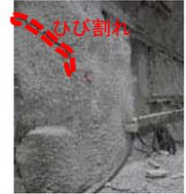
吹付けコンクリートのひび割れ
