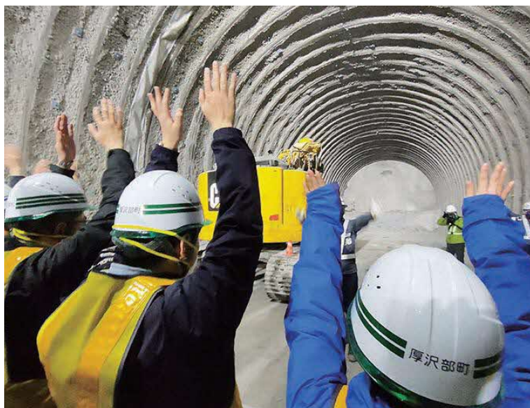
▲目の前でトンネルが貫通する貴重な瞬間を見ることができました。
