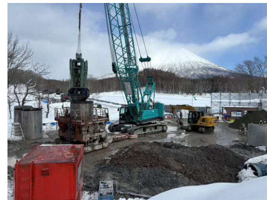
岩塊撤去状況
