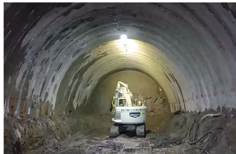
NATM掘削状況
