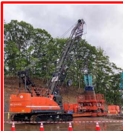
岩塊撤去状況
