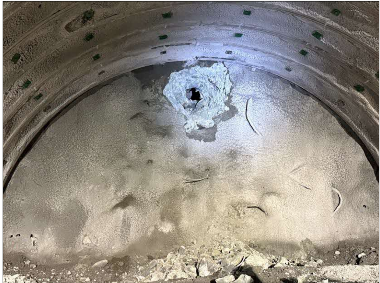
掘削完了地点の状況
