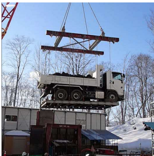
発生土搬出状況(到達立坑部(地上部))
