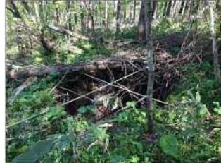
地表面陥没状況
