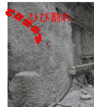
吹付けコンクリートのひび割れ
