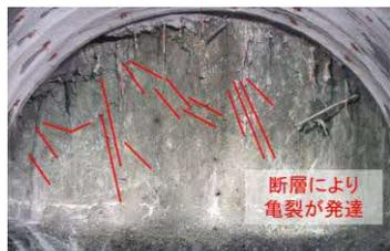
断層により亀裂が発達
