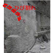
吹付けコンクリートのひび割れ
