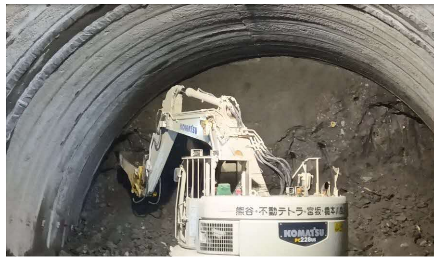
NATM掘削状況
