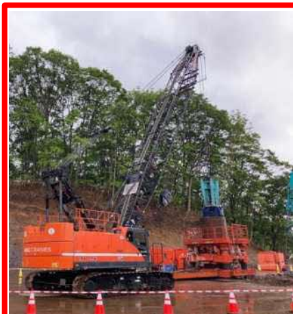
岩塊撤去状況
