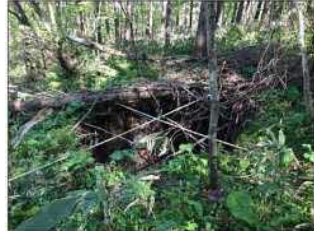
地表面陥没状況
