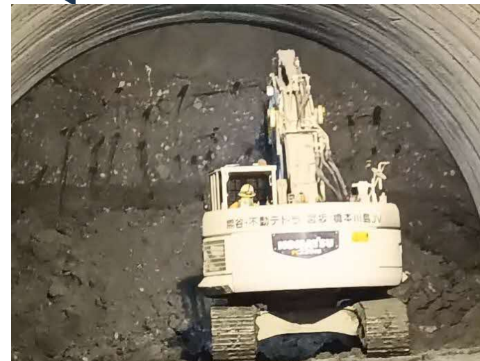
NATM掘削状況
