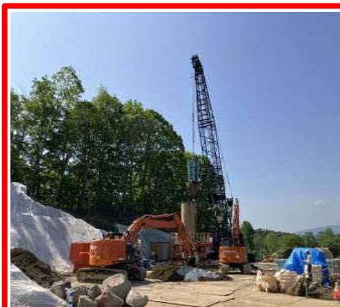
岩塊撤去状況
