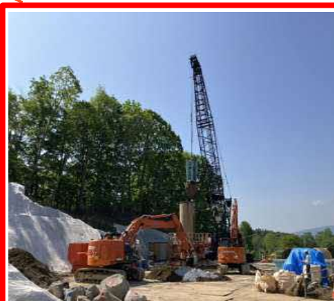
岩塊撤去状況
