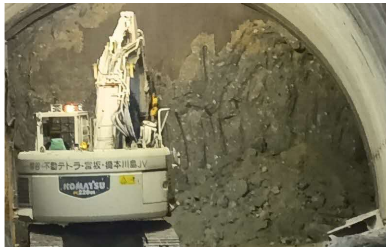
NATM掘削状況
