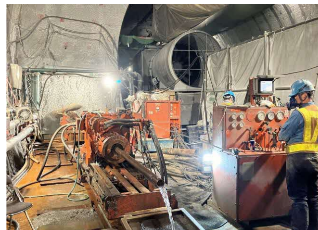
渡島トンネル(台場山) 長尺ボーリング実施状況
