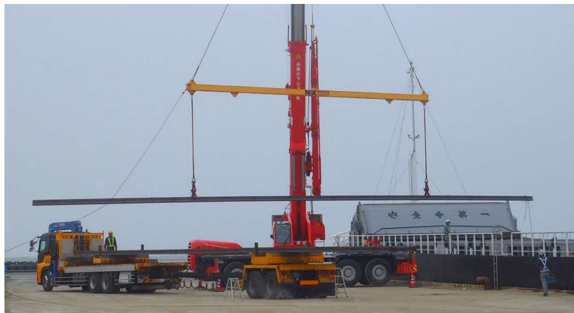
レール陸揚げの様子
