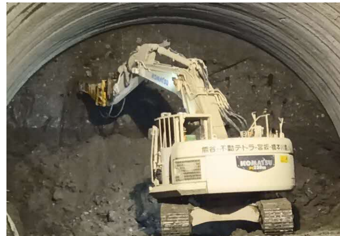
NATM掘削状況
