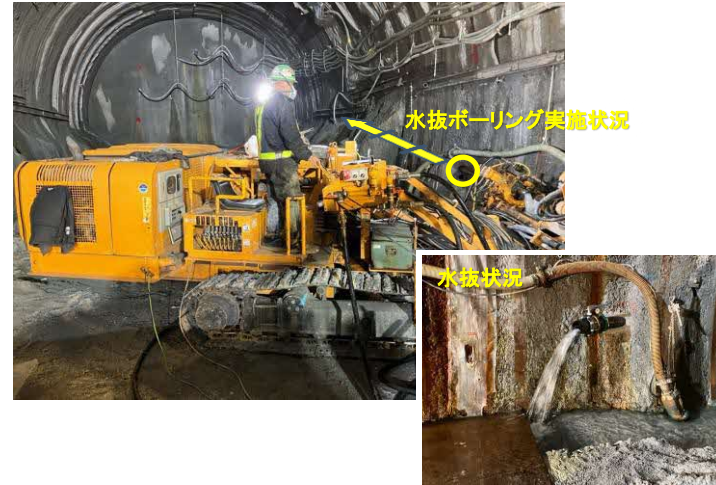
札幌トンネル(石倉) 多量湧水処理状況
