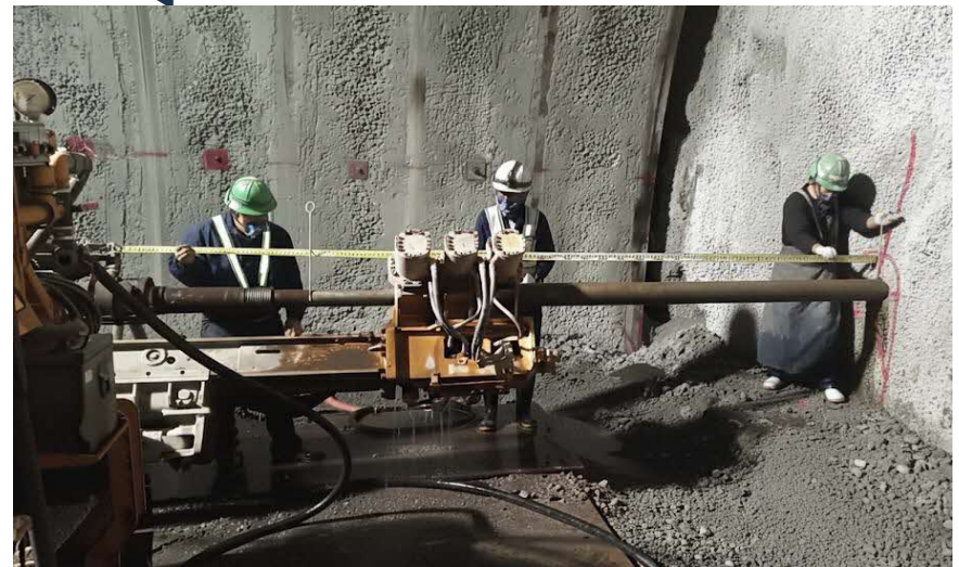
水平ボーリング実施状況
