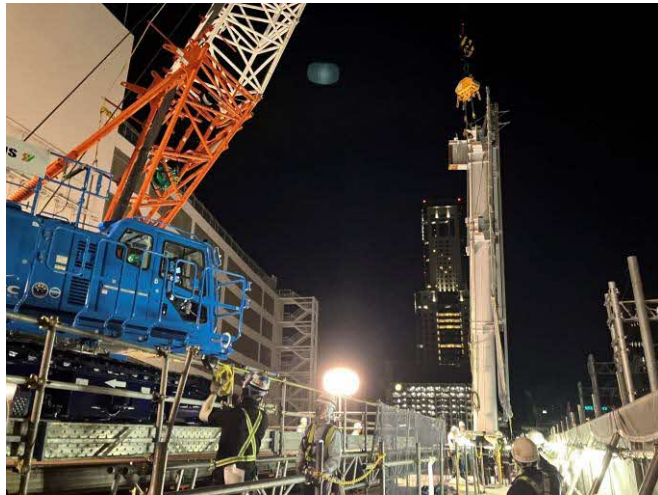
鉄骨建方工事の様子
