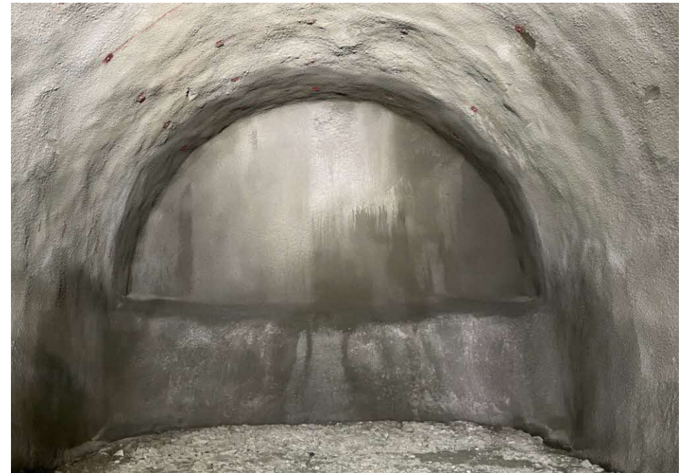
掘削完了地点の状況
