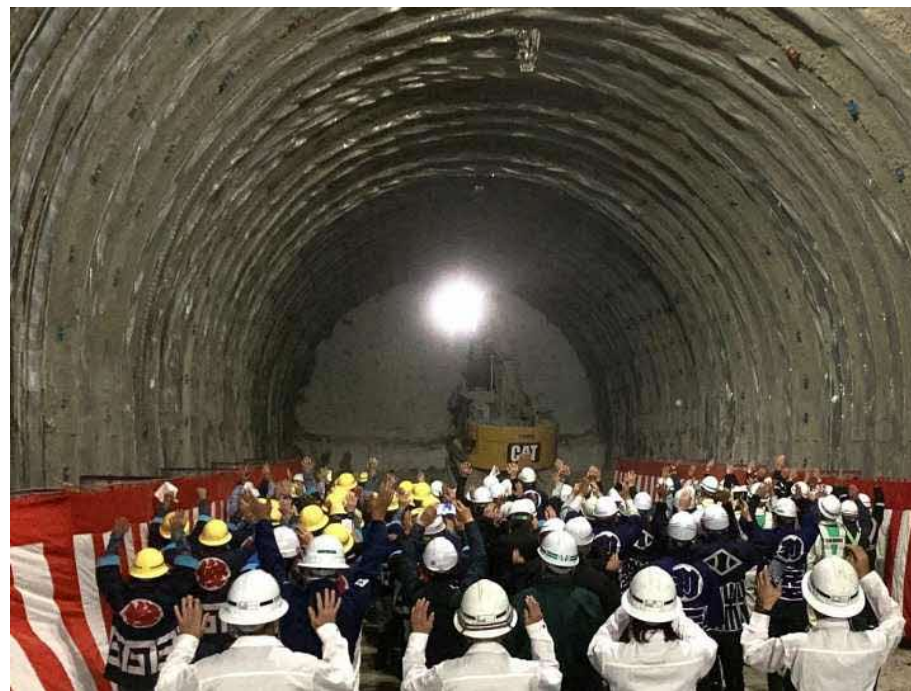
掘削完了地点の状況
