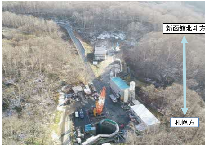
到達立坑ヤード全景
