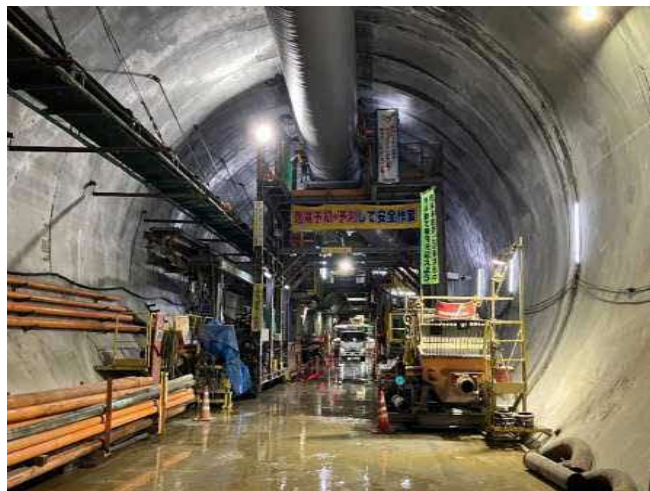
羊蹄トンネル(比羅夫) トンネル坑内状況
