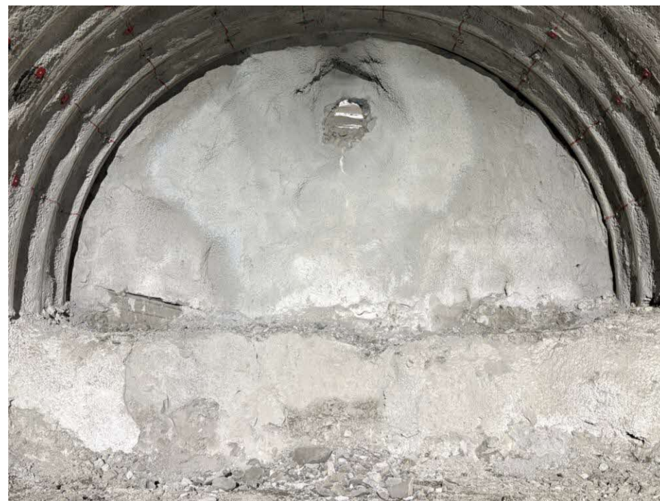
掘削完了地点の状況
