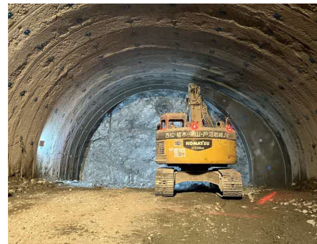
渡島トンネル(台場山) トンネル掘削工施工状況
