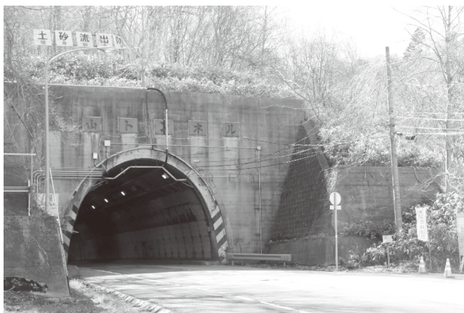
中山トンネル（命の道）
