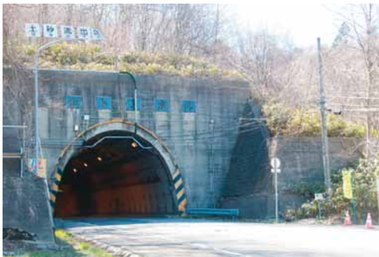
中山トンネル（命の道）
