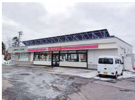
▲屋根上にソーラーパネルを設置
