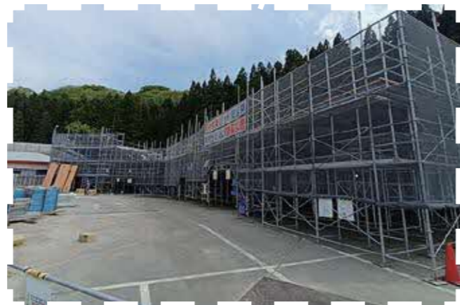
▲イラン・中東情勢の影響は少なからずありますが、 順調に建設工事が進んでいます
