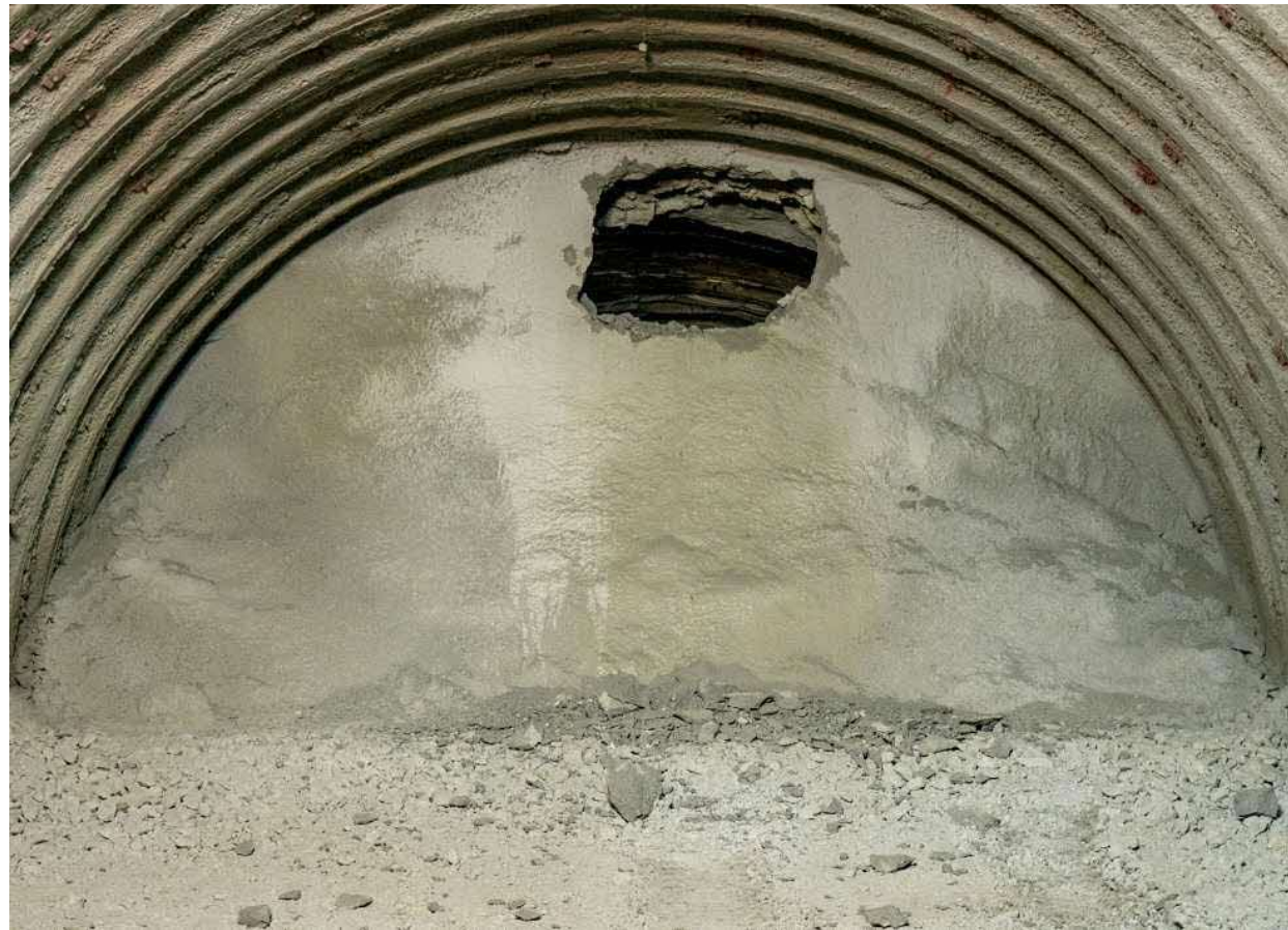
掘削完了地点の状況
