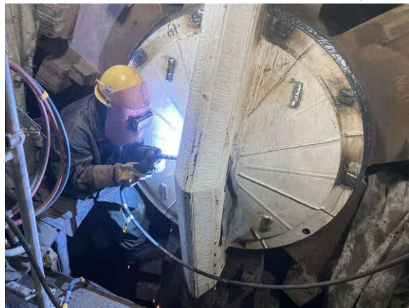
フィッシュテール取付状況
