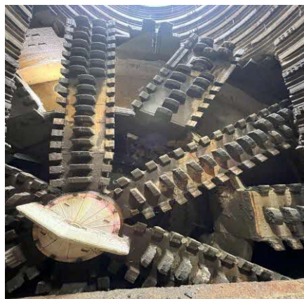
ビット交換作業完了
