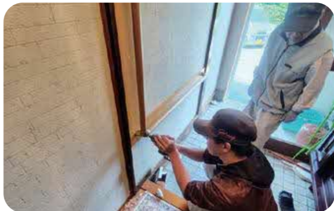
▲手際よく、手すりを設置。
